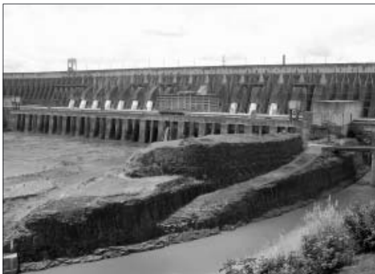
Centrala Itaipudammen med kraftverksdelen.
